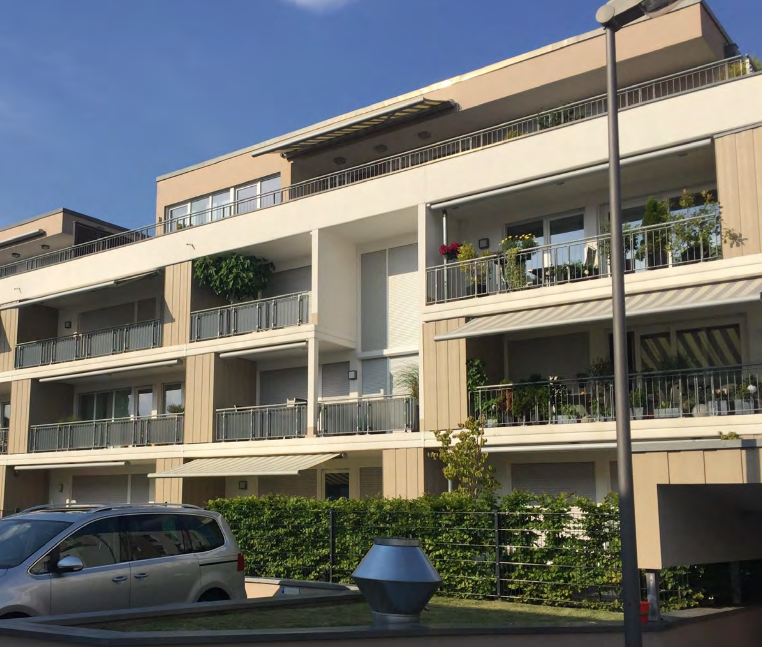
Wohngebäude im Quartier 100 © empirica
